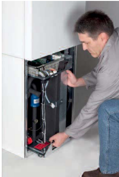
Das Kältemodul lässt sich vor Ort leicht entnehmen und erleichtert so die Einbringung erheblich
